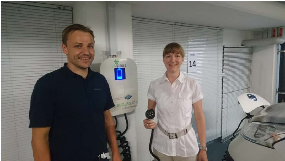
Freuen sich über die neu installierte Ladestation: Martina Miciecki, Direktorin Park Hotel Winterthur und Marc Messmer, Projektleiter E-Mobilität der SAK.
